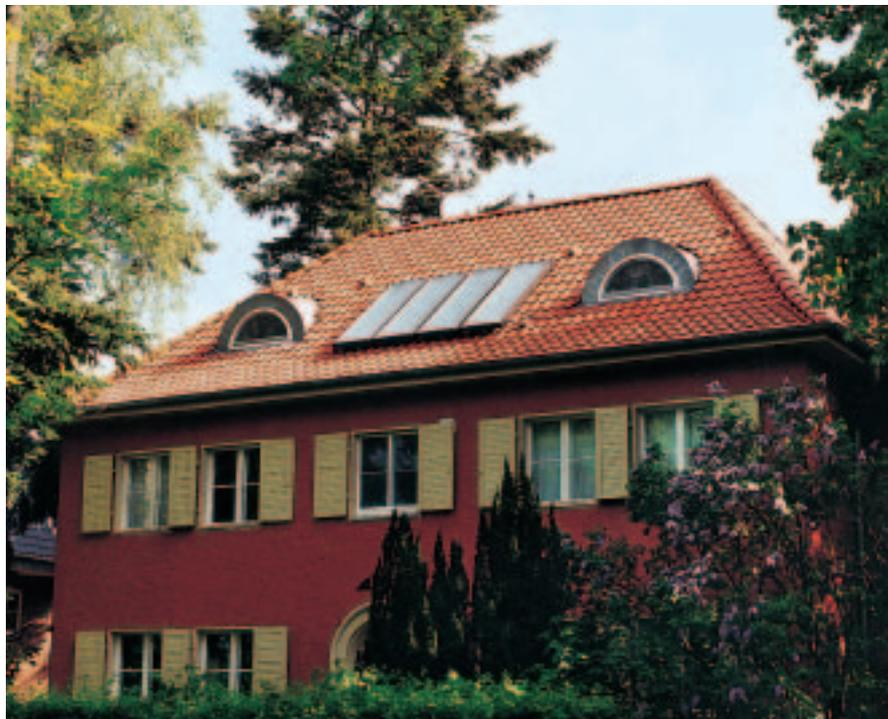
Fig. 38 : Villa de deux logements équipée de 6,8 m<sup>2</sup> de capteurs solaires plats Vitosol 100
