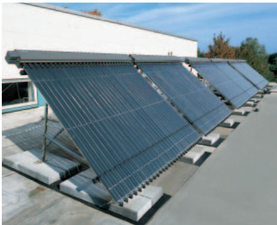
Fig. 39 : Etablissement scolaire à Siegen-Wenden (Allemagne) équipé de 18 m<sup>2</sup> de capteurs solaires à tubes sous vide Vitosol 200
