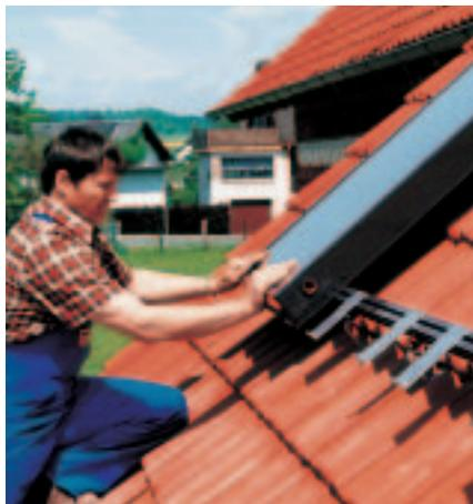
**Fig. 35 :** Le matériel de fixation livré simplifie le montage sur le toit
