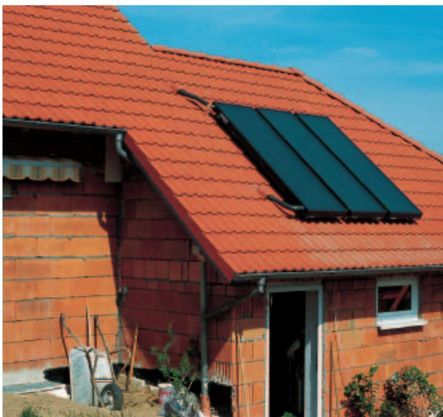
**Fig. 37 :** L'installation solaire fournit de la chaleur dès qu'elle est en place
